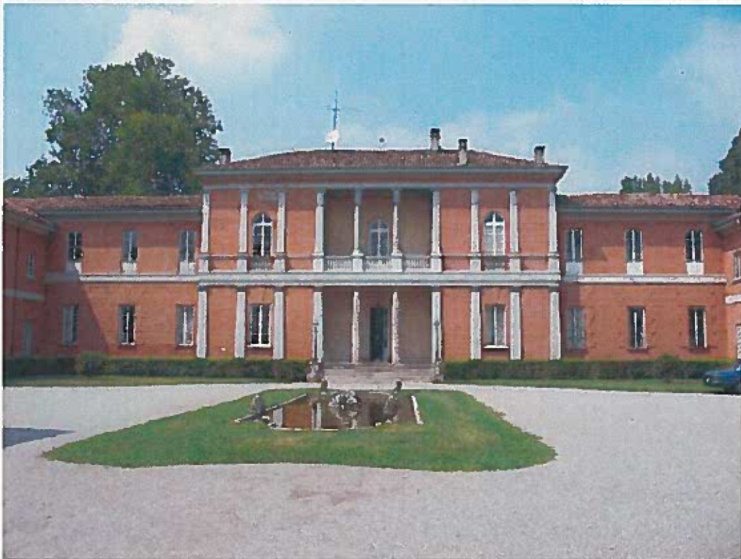
(2006) Prospetto del corpo principale verso il cortile
