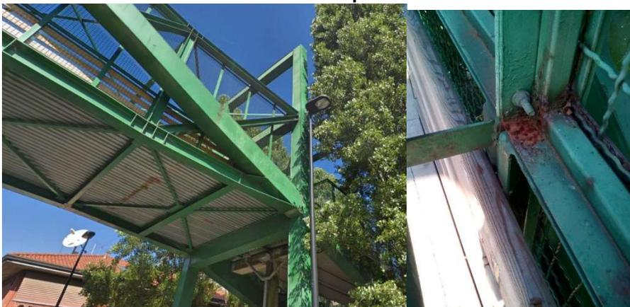
L'intradosso della passerella visto da Via Petrarca con tracce di ruggine ed i segni di infiltrazioni d'acqua
