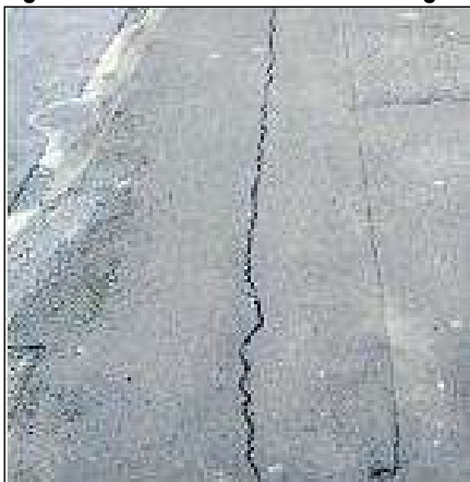
Figura 7: Schema di fessurazione longitudinale
