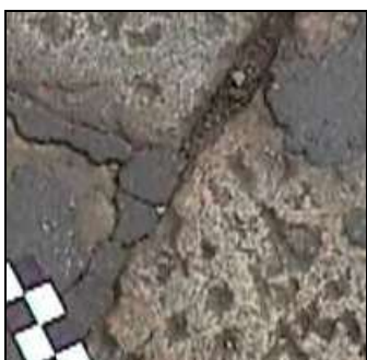
Figura 13: Asportazione di sigillante dai giunti
